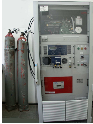
Rys. 19. System zasilania z ogniwami paliwowymi wykonany w wersji przekazywania energii do sieć energetycznej [3]
